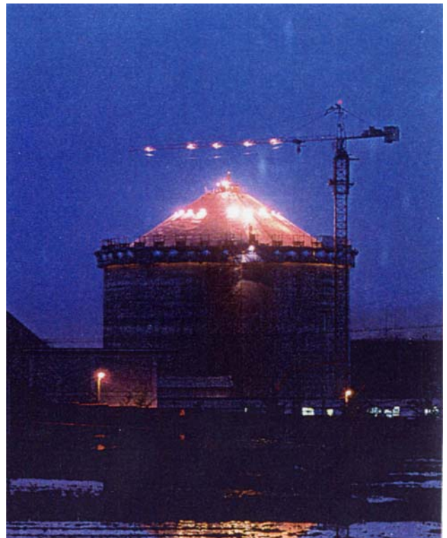
Install of Clinker Silo roof truss Youngwall Hyundai Cement (Korea) 현대시멘트 영월공장 크링커 사이로
