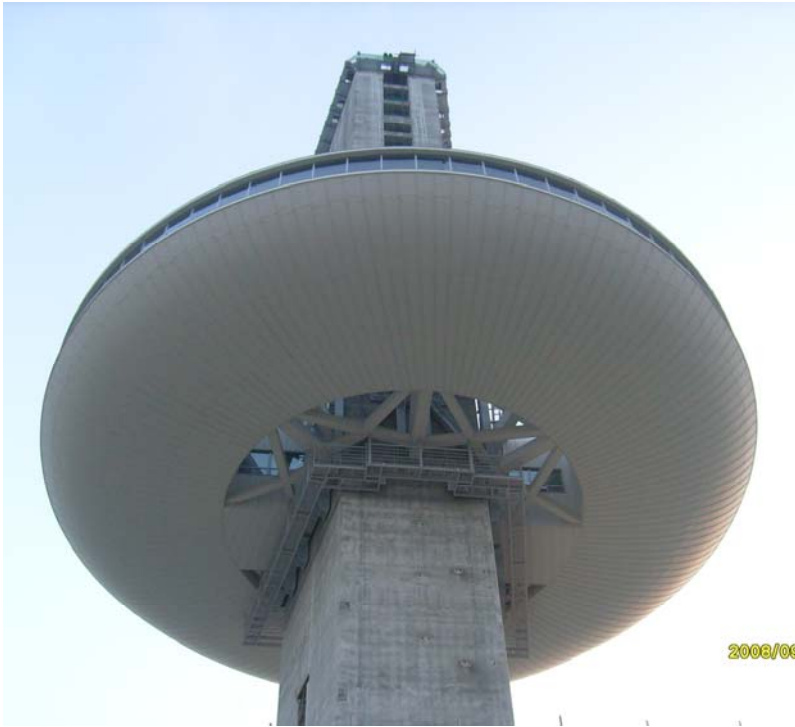
평창 알펜시아 SKI JUMP TOWER 전망대 LIFTING-UP 공사 (680TON*53.0mH) 태영건설 (Korea) 2008.
