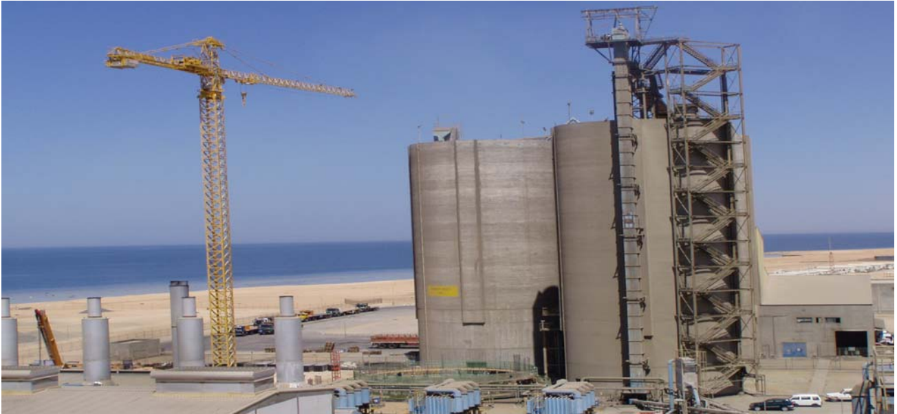
Saudi Arabia (01.'03~06.'03) Tabuk Cement Silo
