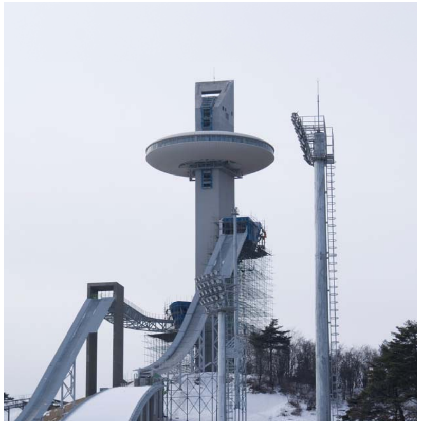
평창 알펜시아 SKI JUMP TOWER 전망대 LIFTING-UP 공사 (680TON*53.0mH) 태영건설 (Korea) 2008.
