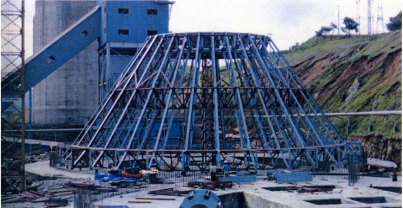
Install of Clinker Silo roof truss Youngwall Hyundai Cement (Korea) 현대시멘트 영월공장 크링커 사이로
