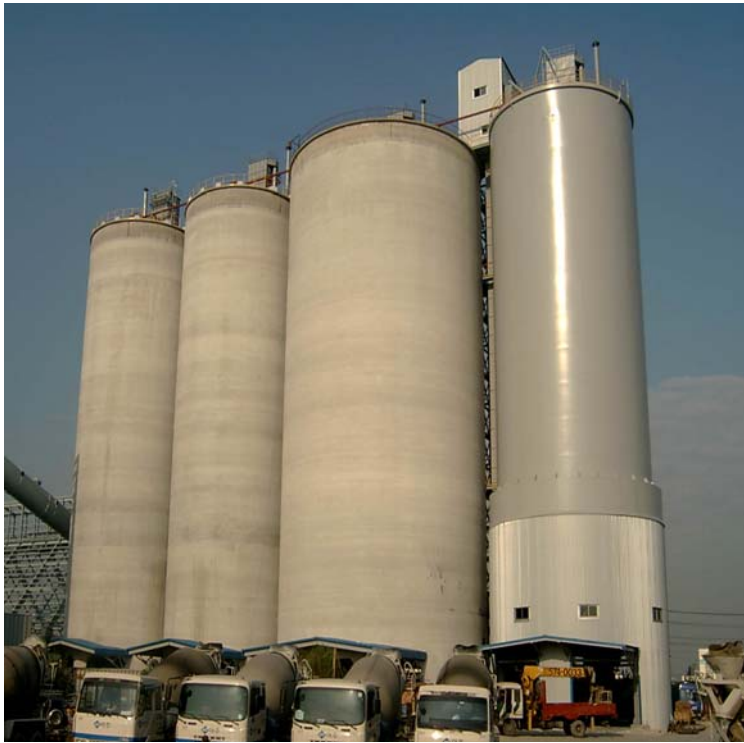
5,000 ton x 2, 10,000 ton Cement Silo x 1 – Aju remicon (Korea) 2004. 아주레미콘 인천 5,000톤 2기, 10,000톤 시멘트 사이로 1기
