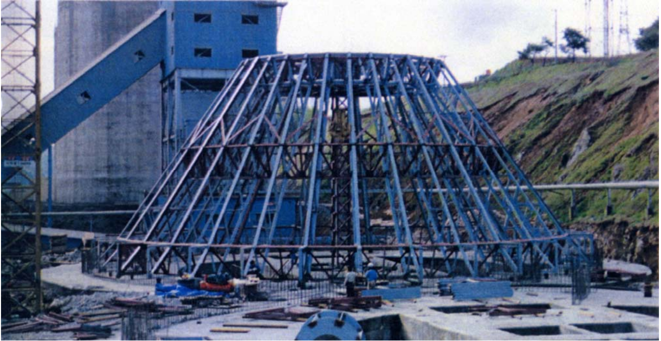
Install of Clinker Silo roof truss Youngwall Hyundai Cement (Korea) 현대시멘트 영월공장 크랑커 사이로
